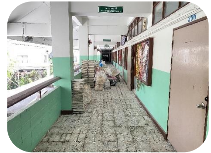
การปรับปรุงอาคารและสถานที่
